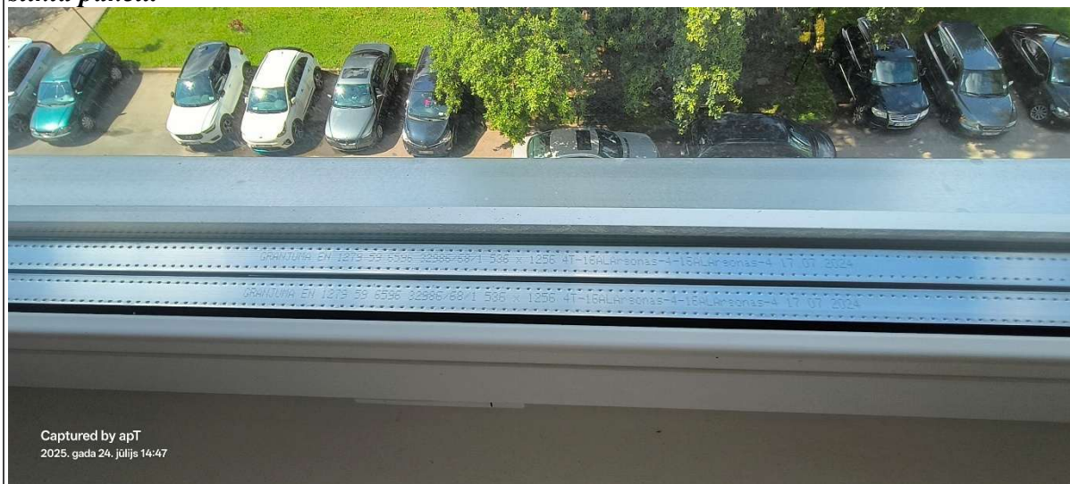
Kāpņu telpas logi mainīti 2024. gadā. Uzstādīti energoefektīvi PVC logi ar divkameru stikla paketi.
