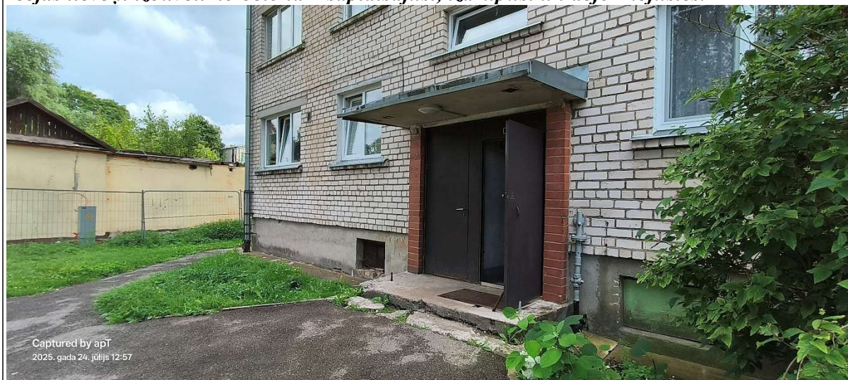
Leejas lieveņi izbūvēti no betona – saplaisājuši, izdrupuši un deformējušies.
