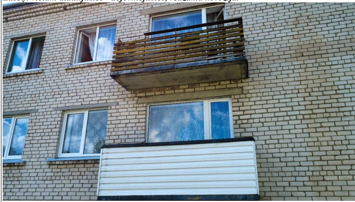
Grīdas seguma hidroizolācijas zudumu rezultātā ūdens infiltrējas konstrukcijā – laika apstākļu un stiegrojuma korozijas rezultātā atsedzas stiegrojums. Lāseņi vietām atdalījušies - deformējušies, redzama korozija.
