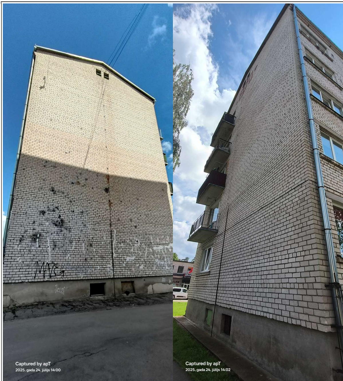
Rietumu – sētas pusē sienā izveidoti ventilācijas atvērumi.
