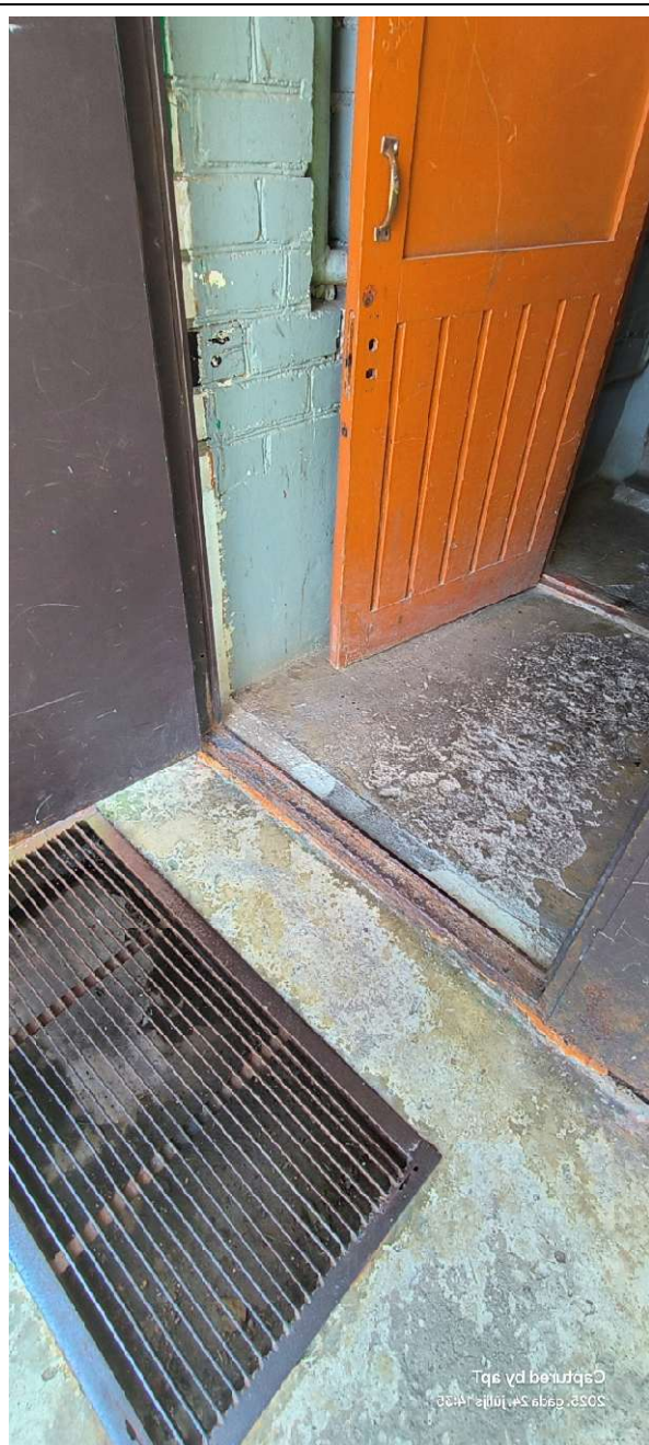
Iekšsienu ķieģeļu mūri krāsoti, vietām bez apdares. Apdare novecojusi.
